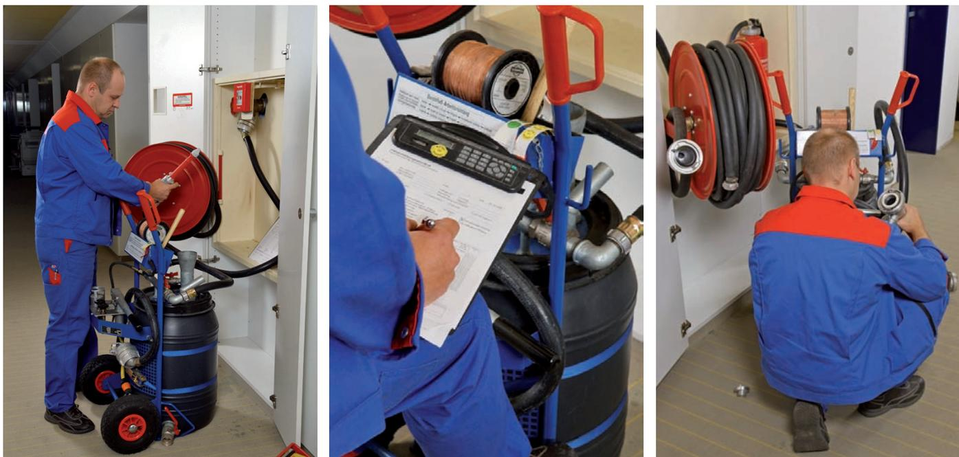
eine Gefahr für das Trinkwasser dar. Eine derartige Löschwasseranlage ist aus brandschutztechnischer Sicht in Ordnung, jedoch unter Hygiene-Gesichtspunkten gemäß DIN 1988-6 nicht mehr zulässig!
